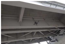
ドローンによる桁下の点検
