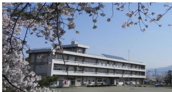
＜勝常小学校校舎＞
