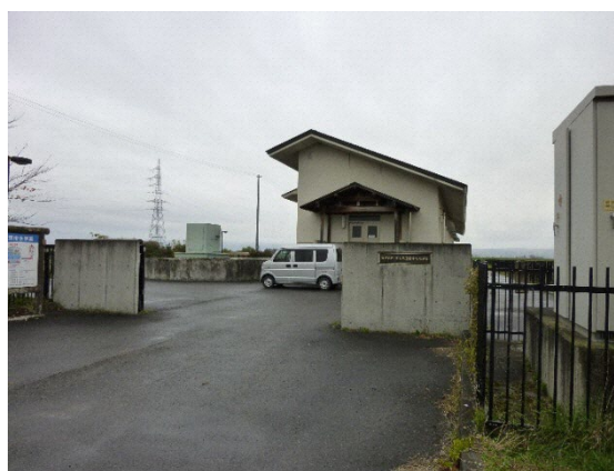
図2-2 勝常地区農業集落排水処理施設
