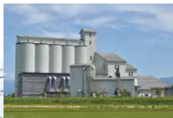
湯川カントリーエレベーター
