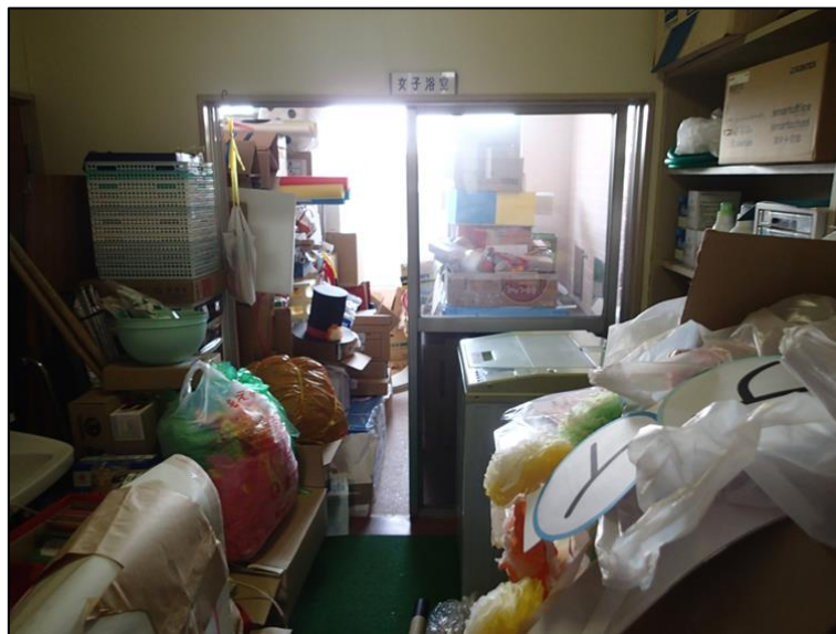
【高齢者コミュニティセンター 女子脱衣室・浴室（倉庫）】
