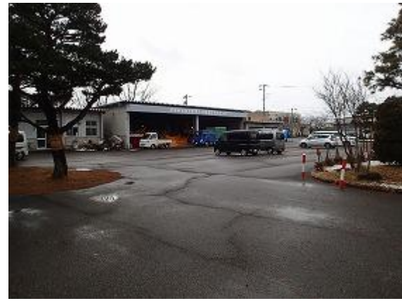
⑩ 会津若松地方防雪生活圏湯川サブセンター
