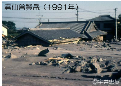
降灰後の土石流
