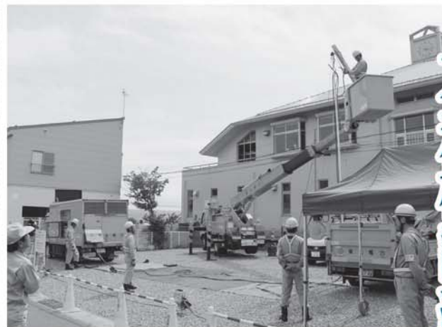
電力応急復旧訓練
