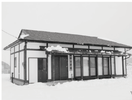
新築となった「田中区集会所」
