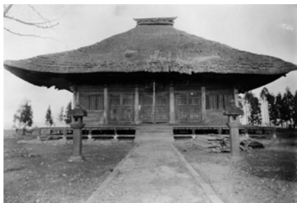
昭和39年 藁葺き屋根の勝常寺薬師堂
