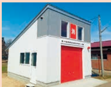
新築した消防ポンプ車庫
