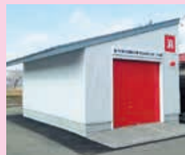
新築した消防ポンプ車庫
