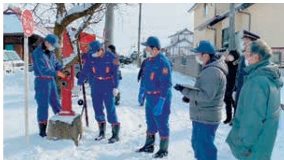
消火栓の開閉点検
