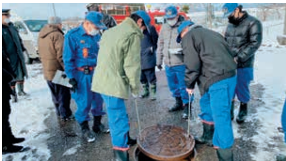
防火水槽の点検
