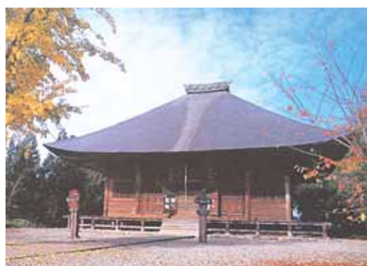
勝常寺薬師堂 やくしどう (会津中央薬師堂)
