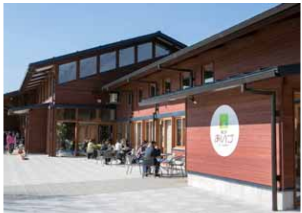
道の駅 がい 外観
