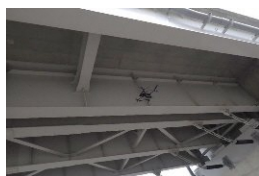
ドローンによる桁下の点検
