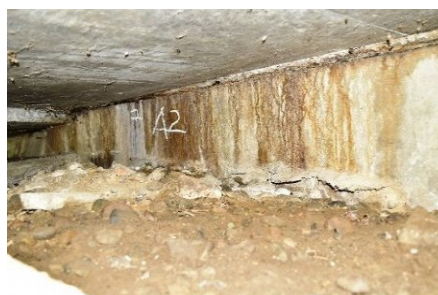
18. 遠背戸橋：RC床版橋 (橋長：4.40m、1983年竣工) 橋台前面の遊離石灰の析出 ※雨水の浸入により、アンカーバーの腐食 が進行する。(迂回路有り)
