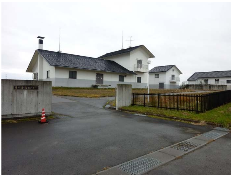
図1-1 湯川浄化センター
