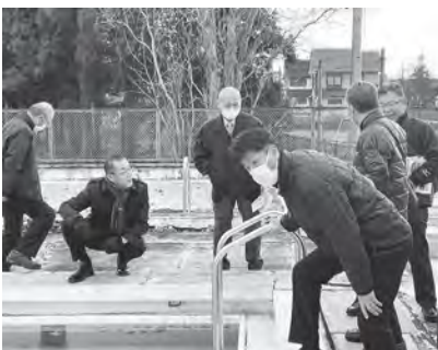
プール施設調査
