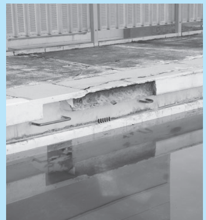
▲ 改修される小学校プール
