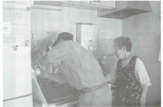
パッキン取替作業
